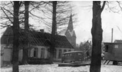
Der alte Konfirmandensaal, (Pastoratscheune) wird abgerissen für einen Neubau des Kindergartens
