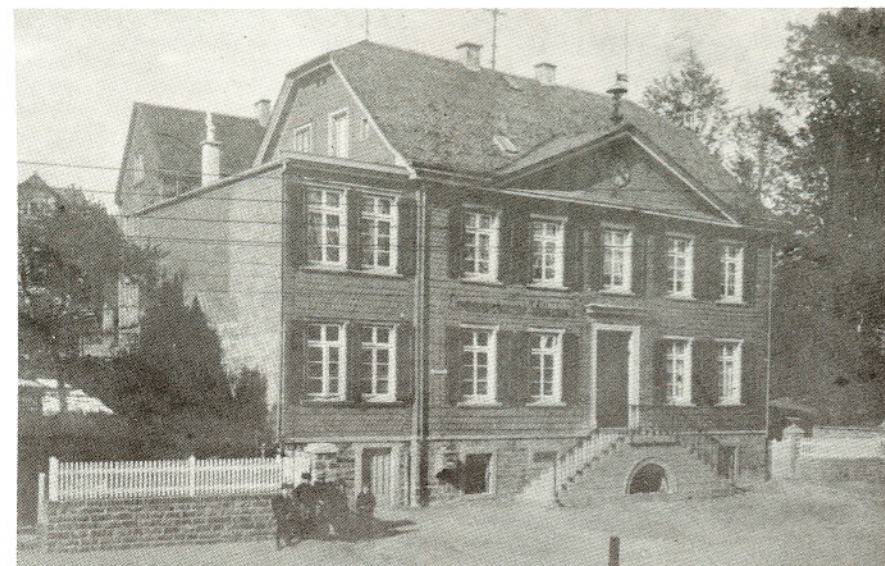
Gummersbach's erstes Rathaus in der Schützenstraße, gebaut von Wilhelm Müller 1853. Von der Stadt Gummersbach 1861 gekauft. Landratsamt von 1861–1886, Rathaus von 1861–1899. Am Vorgiebel die amtliche Uhr, darüber die Uhr Glocken für den Stunden- und Viertelstundenschlag.
